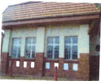
In einem alten Pumpwerk in der Oderstraße wurde das Teltower Wassermuseum eingerichtet. Zu sehen sind hier alte Pumpen, Wasserzähler und Armaturen. Eine Besonderheit ist eine historische Holzwasserleitung (Führungen nach Verrohrung; Tel. 033203-3450).
